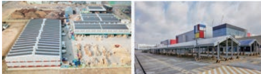
[그림15] 사업장 내 태양광 패널 설치
