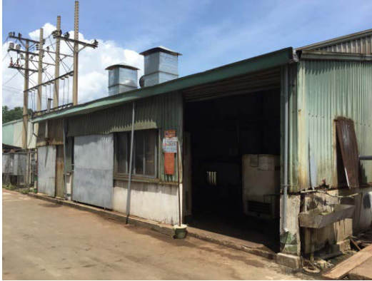
| 그림 20 | Air Compressor Room (Thang Long)
